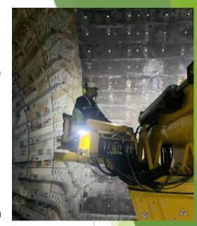
Uno de los logros de nuestra empresa es la velocidad a la que se revisten los molinos en un tiempo récord. En promedio, nuestro equipo tarda entre 7 y 9 minutos en desmontar y montar un solo revestimiento de molino de hasta 4 toneladas de peso, lo que permite retirar rápidamente el revestimiento y minimizar el tiempo de inactividad del molino.
